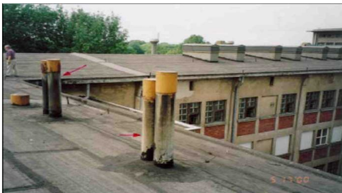
Rys.3. Instalacja wentylacji grawitacyjnej w obiekcie przemysłowym wykonana z rur azbestowo-cementowych [ 5]
