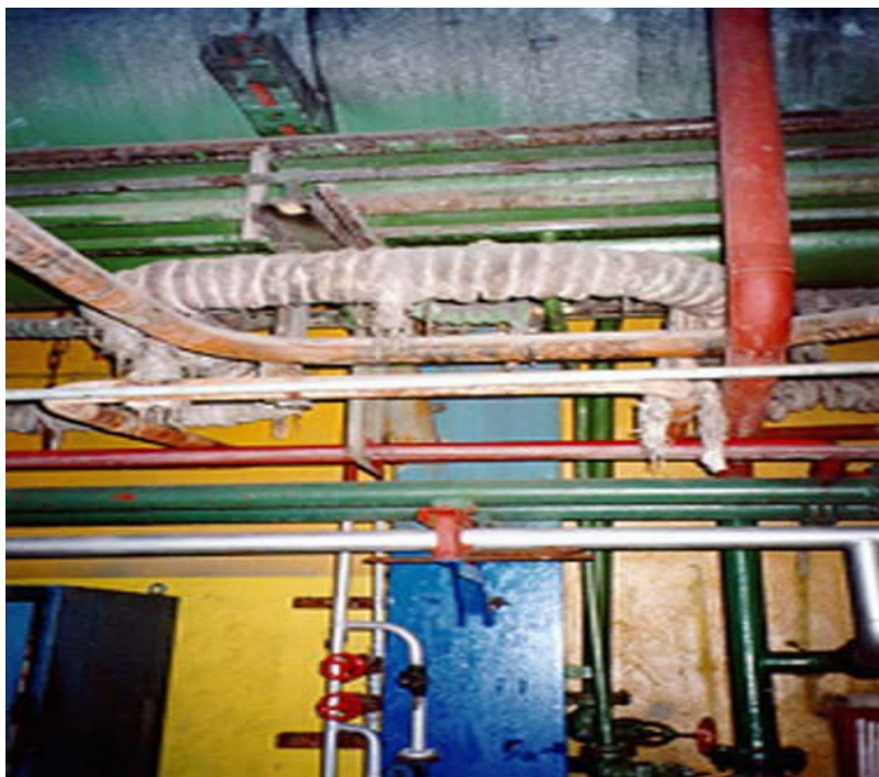
Rys.8. Izolacja rurociągów ze sznurów azbestowych w
