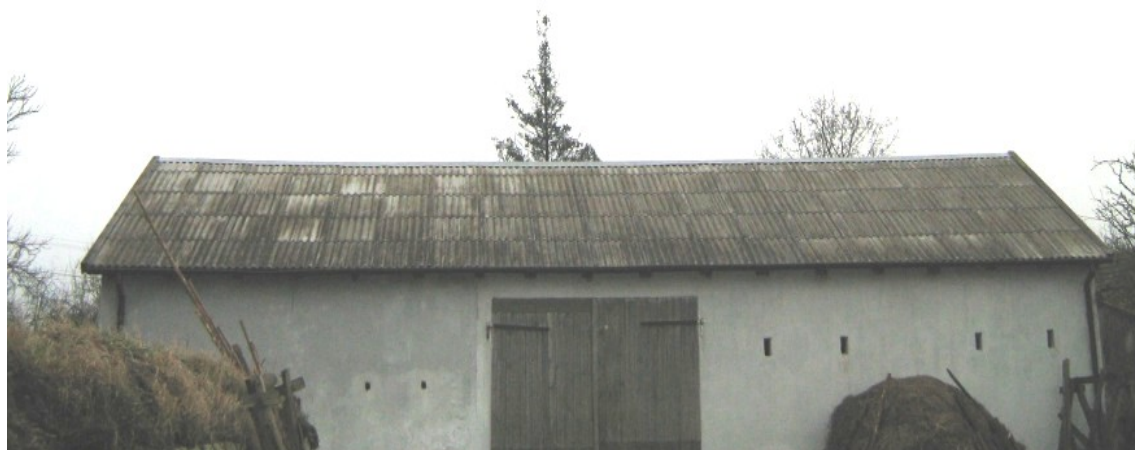
Rys.2. Płyta azbestowo-cementowa falista dla budownictwa „eternit”. Stodoła pokryta eternitem .
