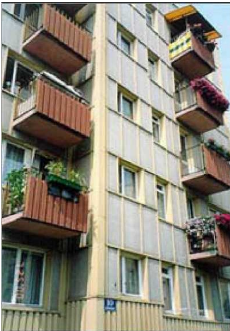
Rys.4. Budynki WK-70 docieplane wełną mineralną na ruszcie drewnianym, pokryte elewacją wykonaną z płyt azbestowo-cementowych płaskich [ 5]
