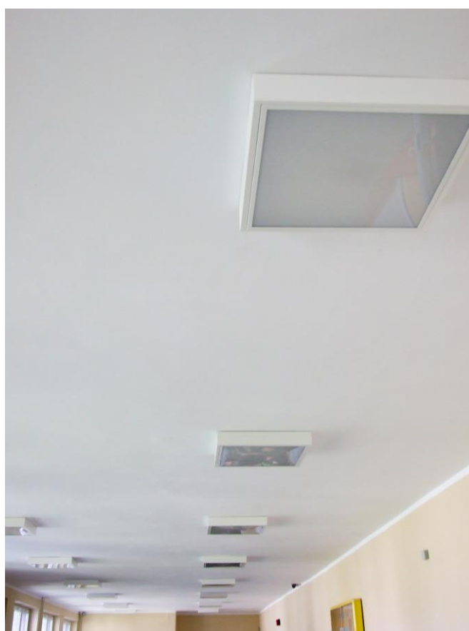
Rys. 6 Nowe oprawy na korytarzu
