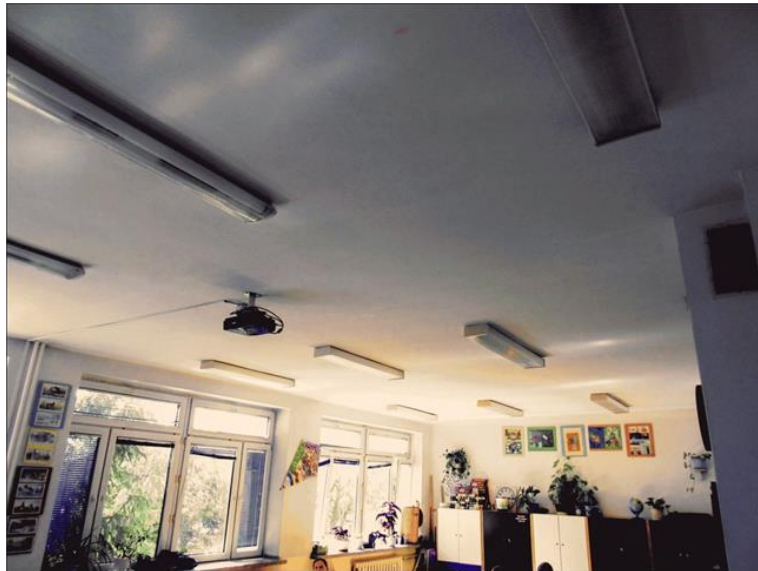
Rys. 1 Przykład zdekompletowanych i zabrudzonych opraw
