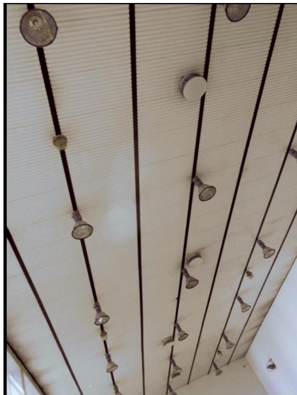
Rys. 2 Ogólny widok na stare oprawy Sali gimnastycznej
