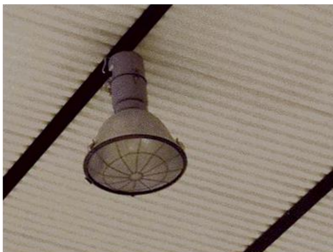
Rys. 3 Stara oprawa na Sali gimnastycznej
